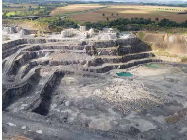
Remise en état, Fresney-le-Puceux (14), Société Carrière de la Roche Blain
